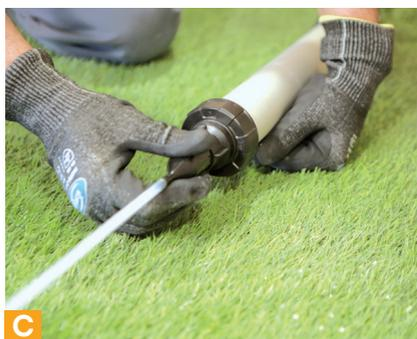
Replacer l'embout du pistolet muni de l'adaptateur et sur lequel est montée la canule avec son tuyau d'injection.
