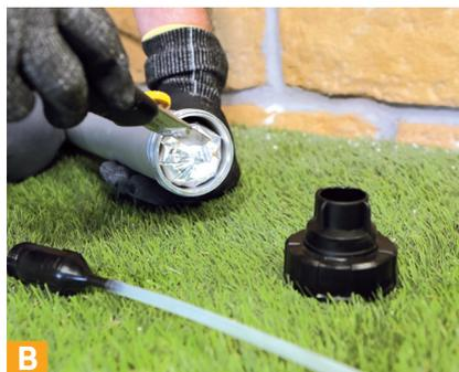
Couper le clips de sertissage à l'aide d'une pince coupante ou perforer le bout visible de la poche à l'aide d'un cutter.
