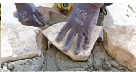
MAÇONNERIE DE PIERRES
