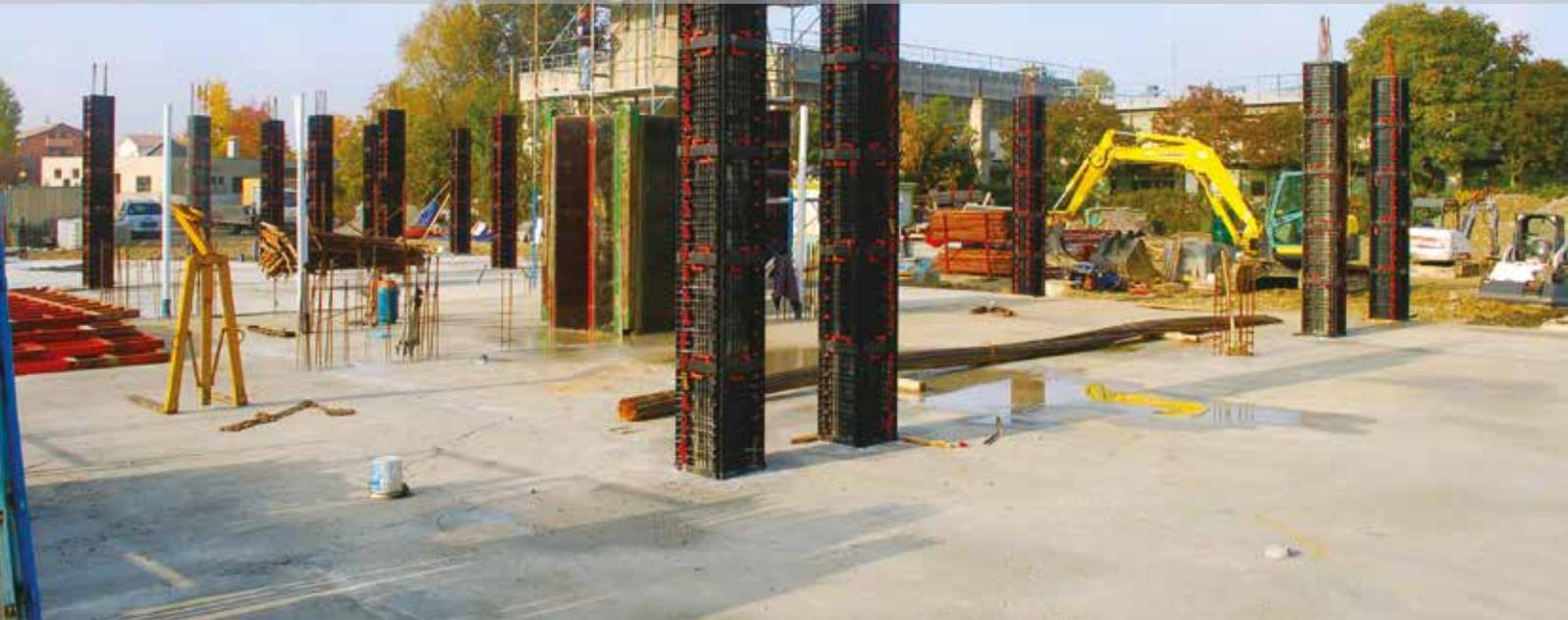
Le système léger, réutilisable et modulaire pour la réalisation de poteaux carrés et rectangulaires
